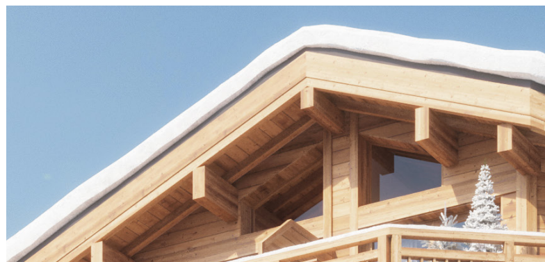
Structure en bois massif
